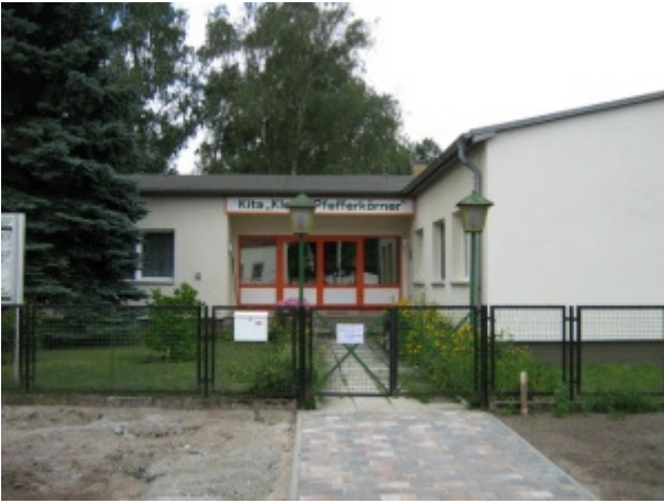
Außenansicht der Kita von vorn
