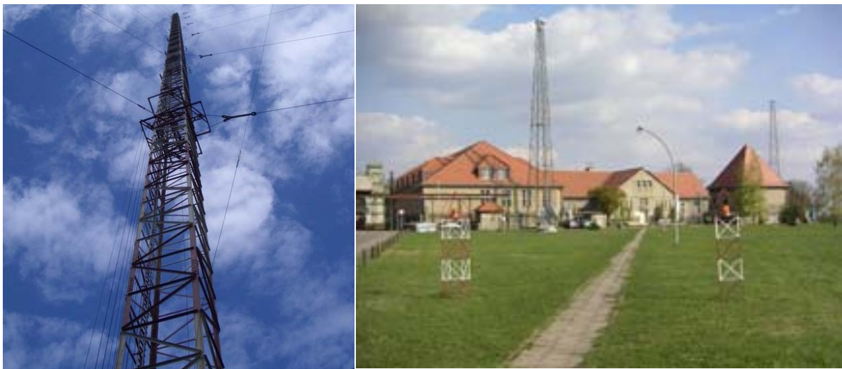
Abb.: Funkmast und Senderhaus 1 am Funkerberg
