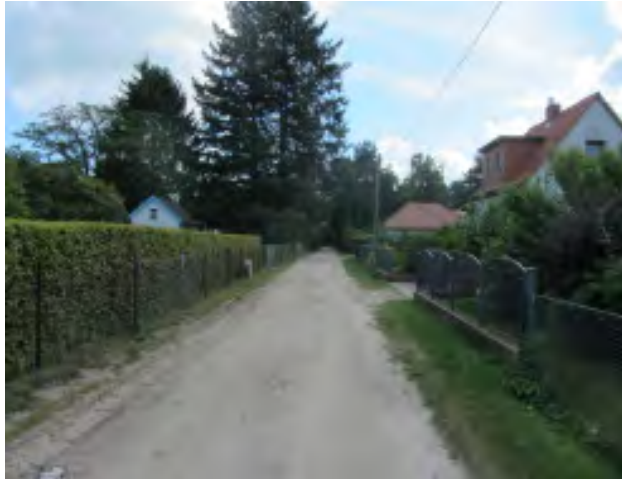
Abb.: Kreuzung Amselstieg/Bürgerwald Straße, Blickrichtung Osten entlang des Amselsteg
