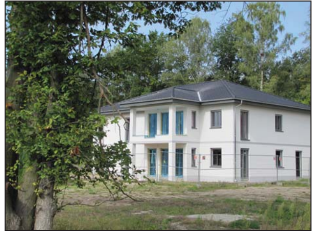
Bautätigkeit im Plangebiet
