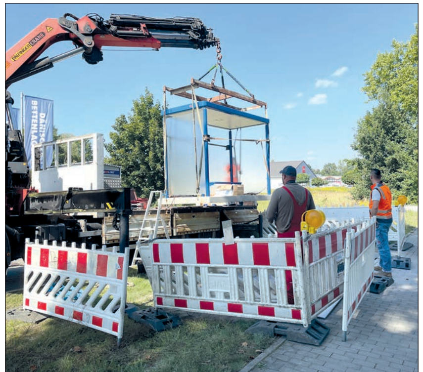
Eine neue Buswartehalle wird im Bereich Karl-Liebknecht-Straße/ Schulstraße in Zeesen aufgestellt. Foto: Stadt Königs Wusterhausen
